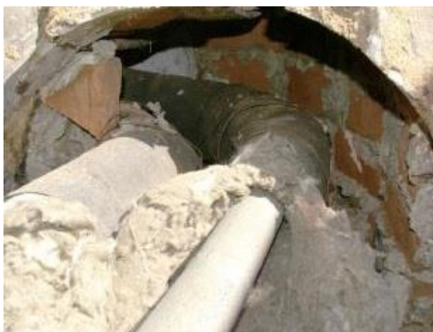
Rys. 2. Przyłącze ciepłownicze
