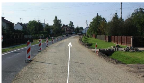
Rozkładanie kruszywa w celu optymalizacji uziarnienia
