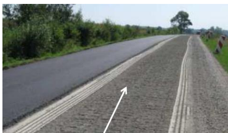
Rozsypywanie cementu w ilości 1,5 - 7,0 %
