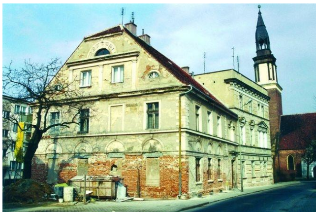
Rysunek 1. Budynek przed renowacją elewacji
