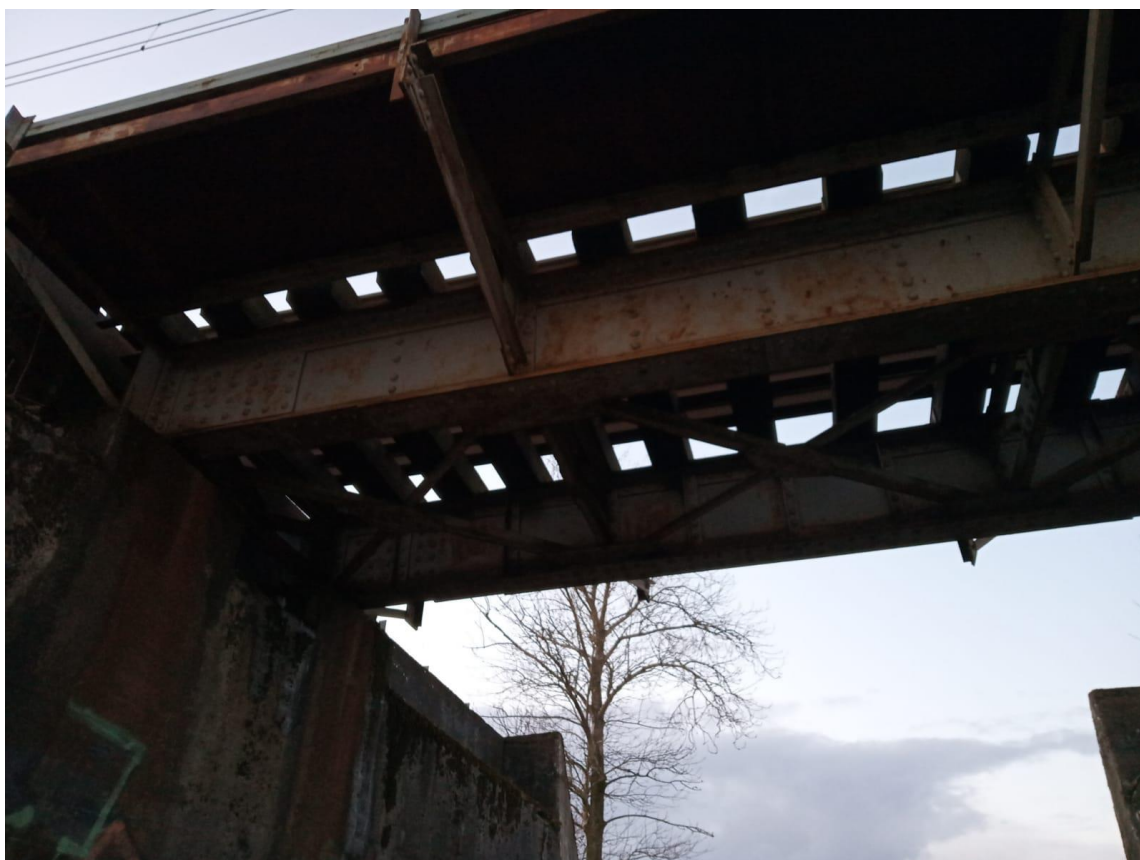
Rysunek 3. Remontowany wiadukt
