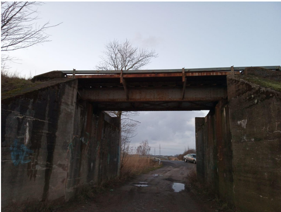
Rysunek 2. Remontowany wiadukt
